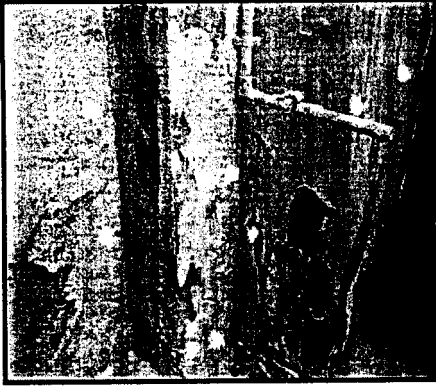
صورة (٥): استخدام الأسمنت البورتلاندي في ترميم جدران المدرسة الأميرية. ناظرًا نحو الشرق.
