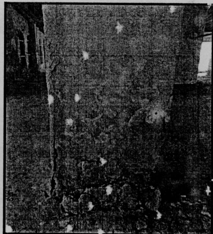
صورة (١٣): نشع المياه بالجدران وانتفاخ الطبقة الخارجية وتبلور الأملاح بالرصيف البحري - العقير. ناظراً نحو الشمال الشرقي.
