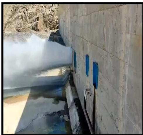
صورة (٧) فتح بوابات سد رايح
