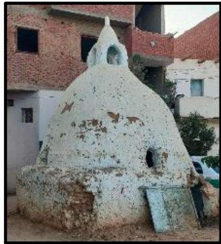
لوحة ( ٢٨ ) تبين الواجهة الرئيسية الشرقية لقبة الشيخ مكي./ تصوير الباحثة
