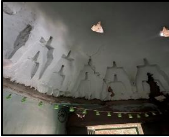
لوحة ( ٢٢ ) تبين قبة الشيخ سعيد من الداخل ويظهر بها منطقة انتقال القبة وهي البلاطة الأفقية المثلثة وأعلىها زخارف من أشكال هندسية وبها المقصورة الخشبية - تصوير الباحثة
